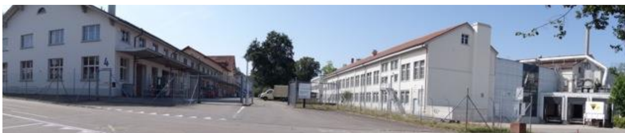
Abb. 17: Die schon bald frei werdenden Zeughäuser können unmittelbar umgenutzt werden.
